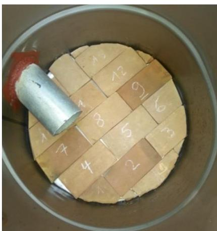
**Me 26** 9-14h Après contrôle rigoureux de leur bon état, achat de briques pour le fond du four, taille et disposition terminées. Problème de pas-de-vis européen avec la bombonne de gaz haïtienne !
