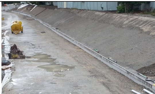
Voie verte du CEVA: mur continu de béton vertical, "sens unique": retour aux quartiers de villas en haut à d. impossible.
