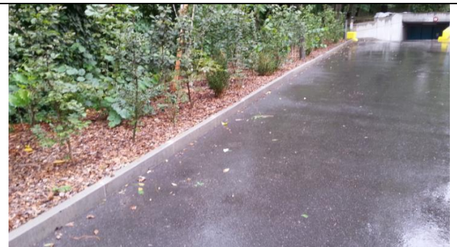
Vers le nouveau Prieuré, Gradelle, bordure ininterrompue: tout ce qui tombe sur la chaussée finit dans le garage souterrain (en haut à d.).
